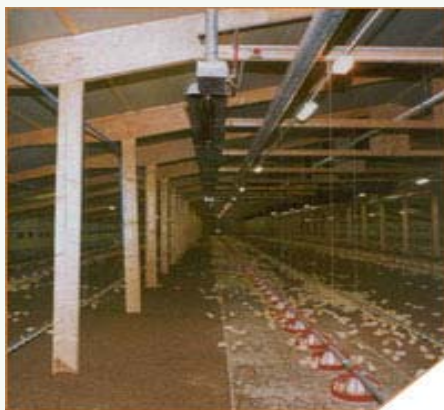
شکل ۳- تصویری از یک گرماتاب در یک مرغداری
