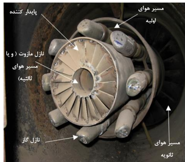
شکل ۵- نمایی از مشعل و اجزای آن [۳]
