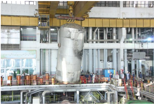
شکل شماره ۴: نمایش پوسته هیتر شماره ۸ هنگام دمنواژ.
