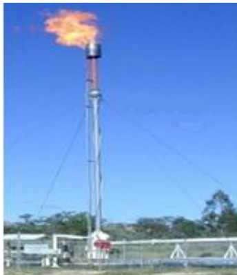
شکل ۵- مشعل جهت سوزاندن گاز متان کم عیار [۱۰]
