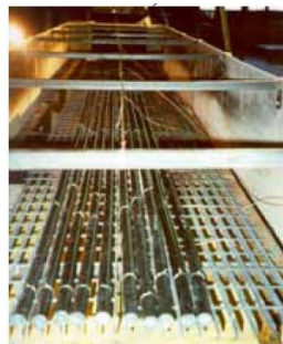
شکل ۱- نصب کابل‌ها بوسیله بستن آنها روی شبکه فولادی [۷]
